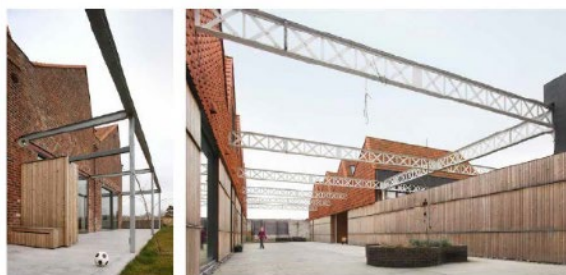
Verbouwing van een reëlabriek tot een project voor 6 woningen, 1 atelier en 2 kamoruimtes in Ronse, Volk architecten
