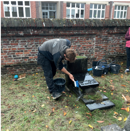
Stap 3: nat maken en sopje aanbrengen met borstel.
