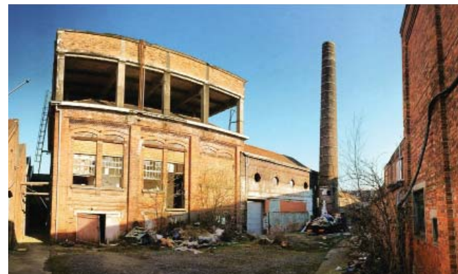
MACHINEGEBOUW MET WATERBAK EN SCHOUW
