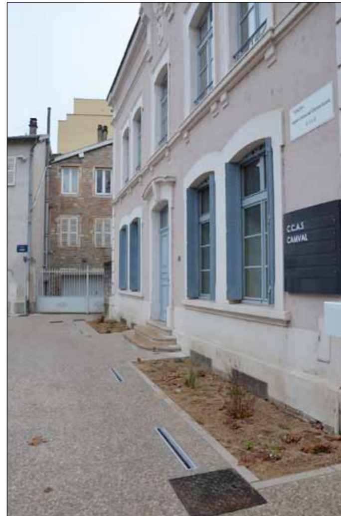
Exemple de barreau encastré au sol au pied de la façade
